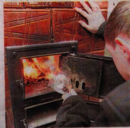
Plastikowe butelki to jedne z najczęstszych śmieci, które lądują w piecach i niosą za sobą najwięcej zanieczyszczeń
